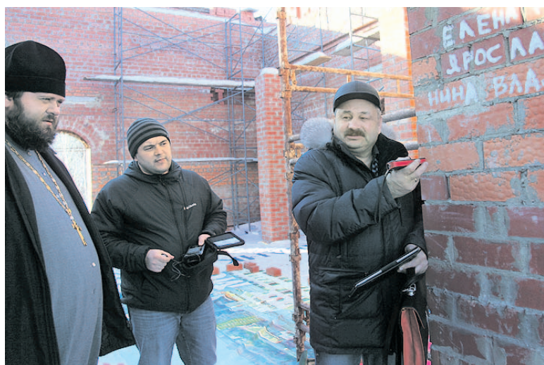
Так на местности происходят замеры длины и ширины помещения. Затем специалисты все рассчитают и составят план, где и сколько ставить светильников.
